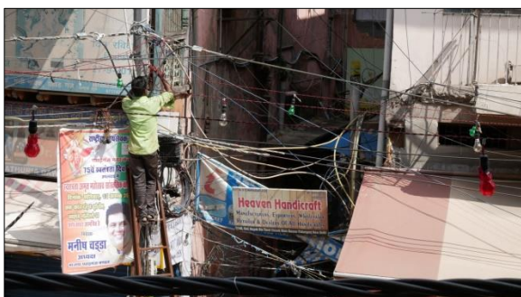
18. 8. Vždy náročná práce elektrikáře
